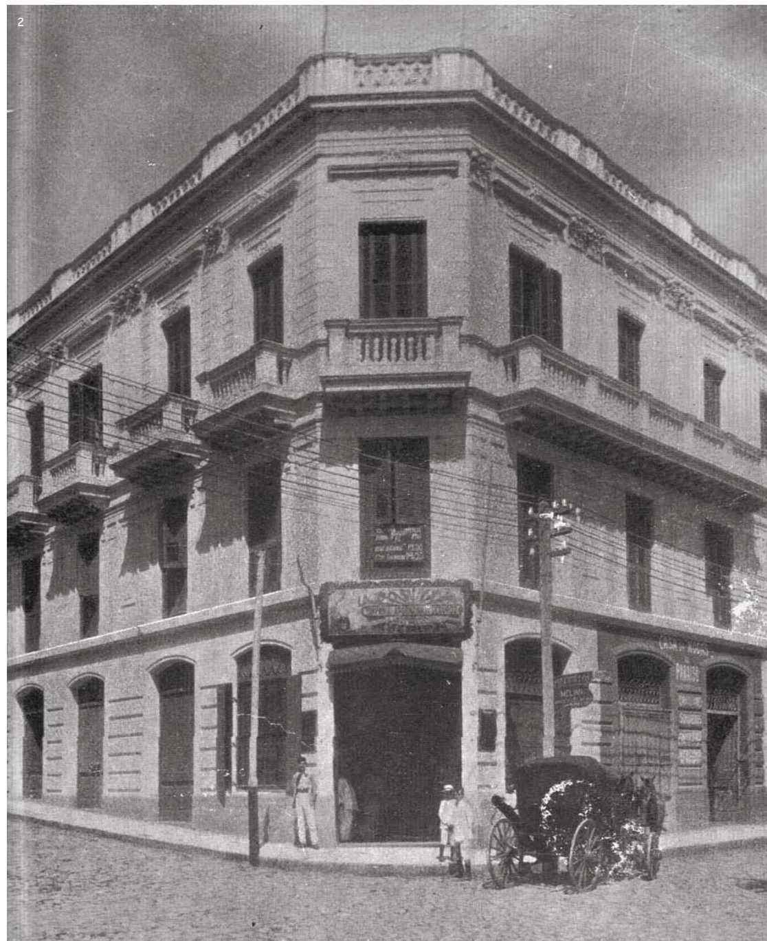
EDIFICIO QUE OCUPABAN LA COMPAÑÍA DE SEGUROS "LA POSITIVA" Y LA CAMARA DE COMERCIO
